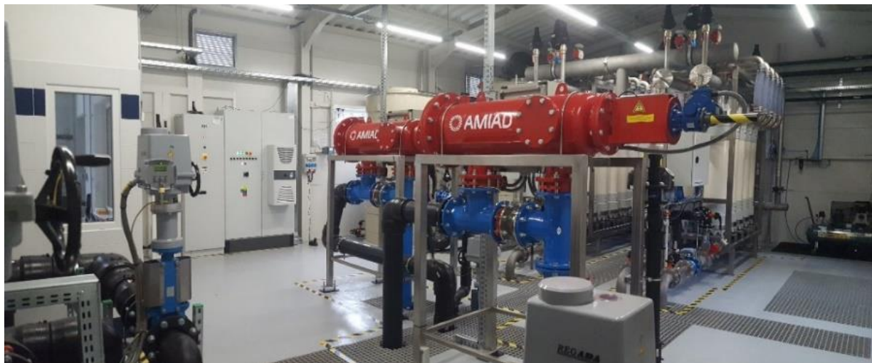
Celkový pohľad na úpravňu, v popredí automatické samočistiace filtre SAF6000
