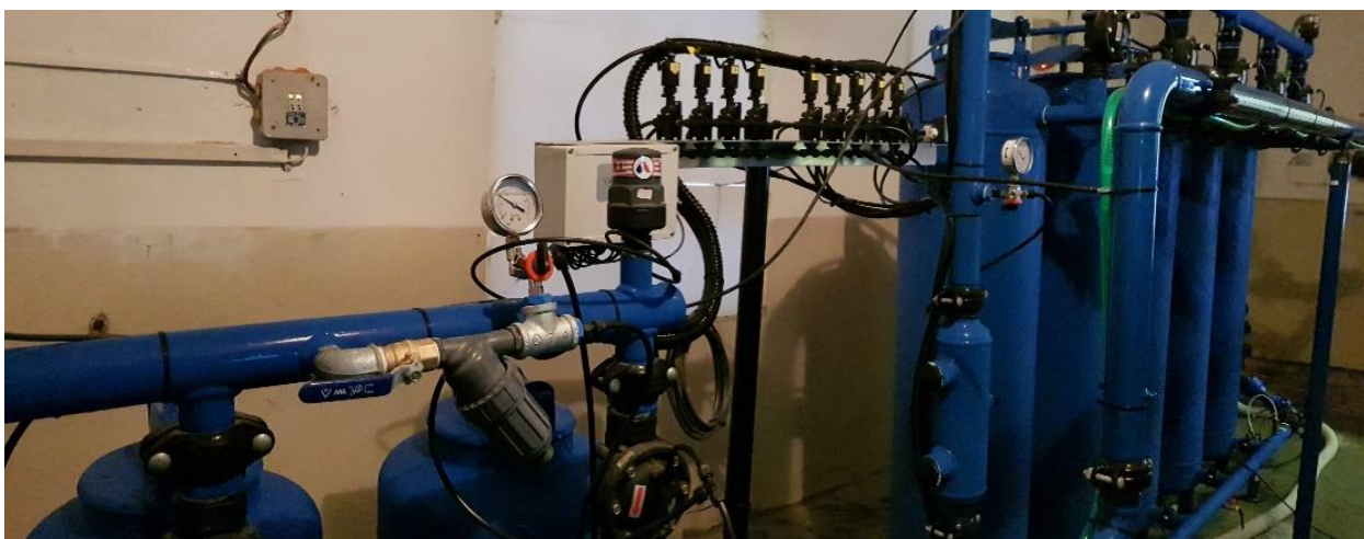
Pohľad na hlavný filtračný stupeň tvorený 5 ks tlakových média filtrov.
